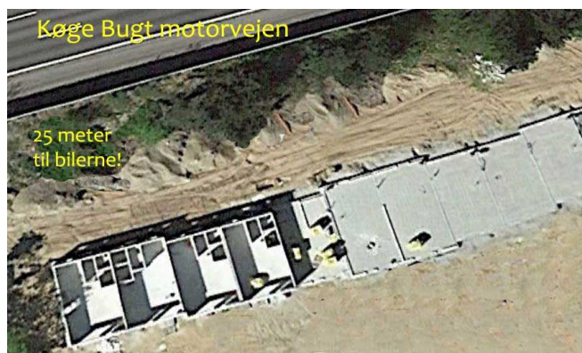
Rækkehuse under opførelse, set fra luften. Soveværelset ligger på 1. sal, 25 m fra motorvejens køretøjer.
